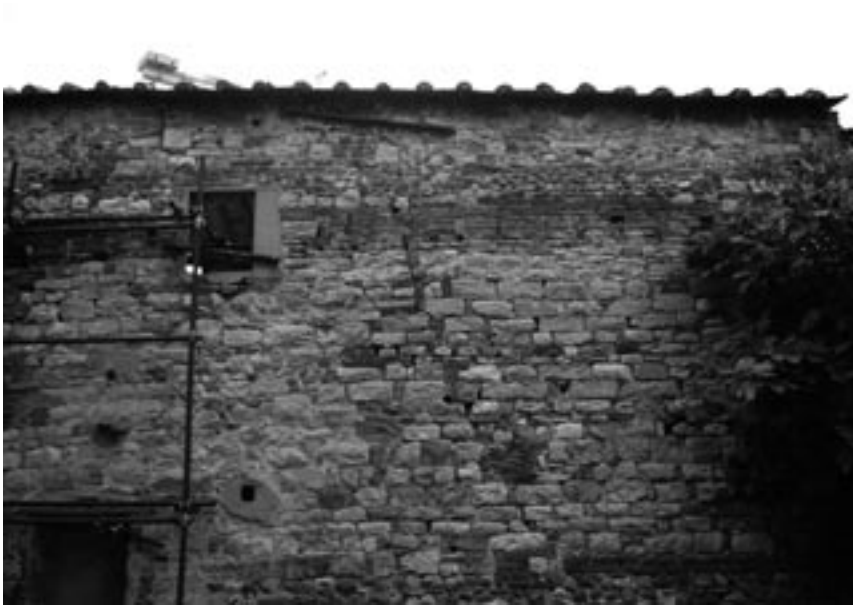
Fig. 2. Resti di una parete della chiesetta di Sant'Abbondio in località Santa Gonda
