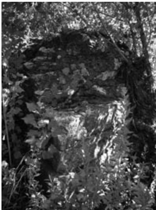
Fig. 3. Base di un pilone del Ponte Petrino in prossimità della sponda destra del fiume Bisenzio
